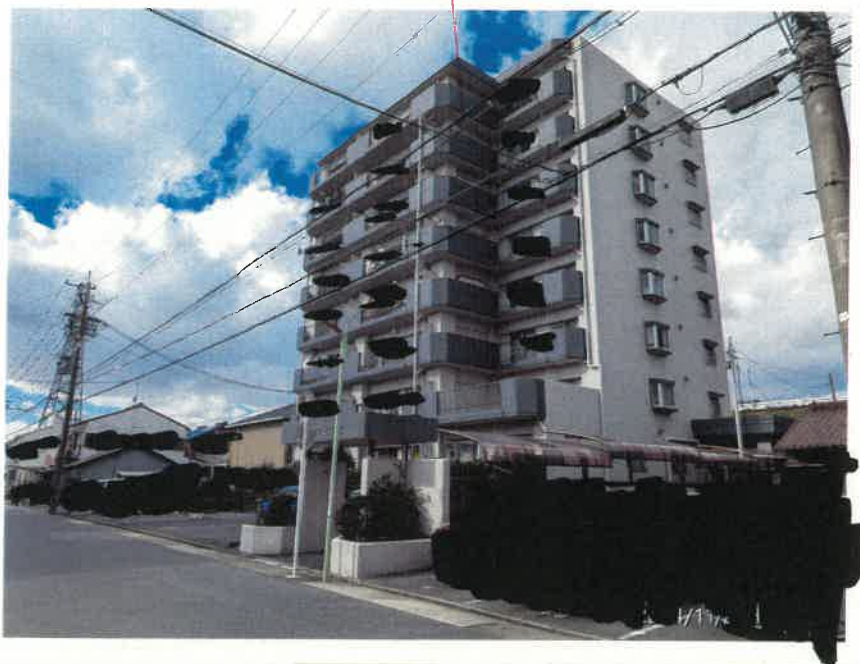
物件2建物を含む一棟の建物 (ユーハウス上堀越)
