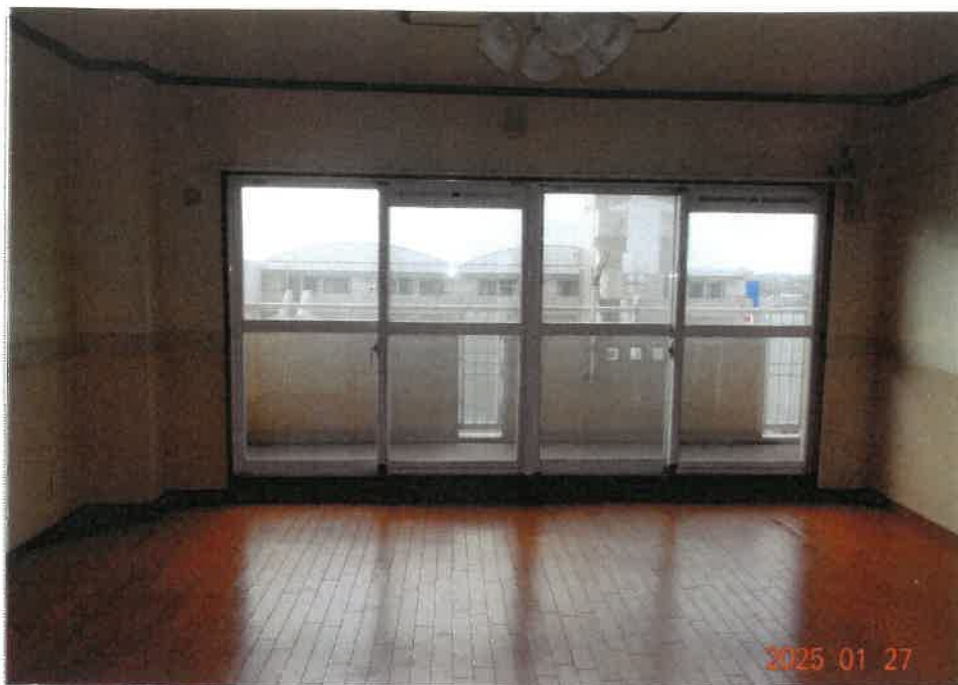
③ 屋内の状況 (居間・食堂)
