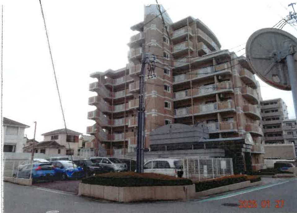
① 北西側から見た本件建物を含む一棟の建物、敷地権土地符号1の状況
