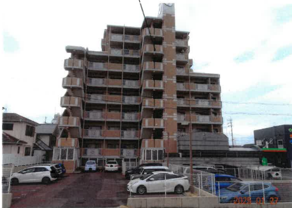
② 北側から見た本件建物を含む一棟の建物の状況
