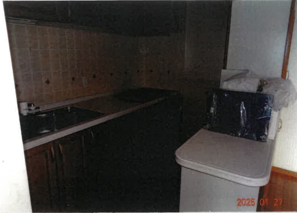
⑤ 屋内の状況（台所）
