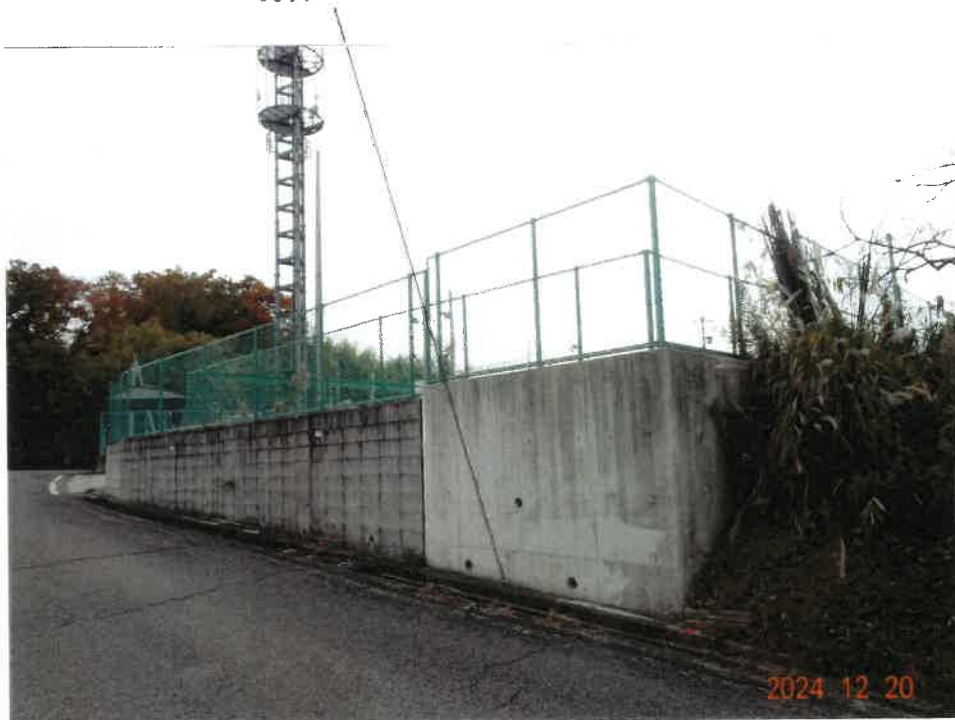
② 北西側から見た物件 2 土地の状況
