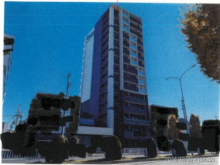
物件1 建物を含む一棟の建物 (プレサンスNAGOYAファスト)
