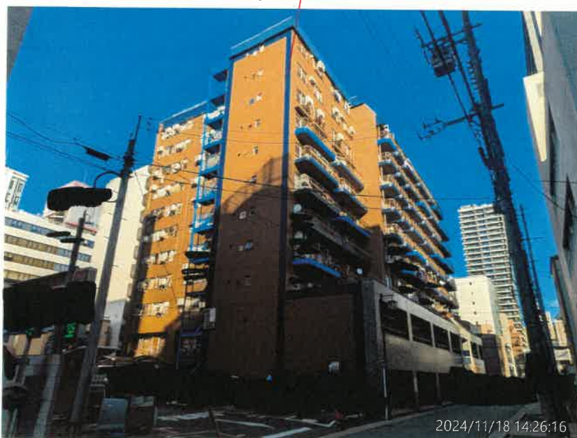
物件1 建物を含む一棟の建物 (チサンマンション栄)
