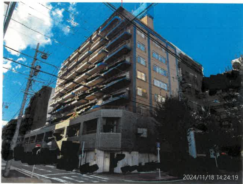
物件1 建物を含む一棟の建物 (チサンマンション栄)
