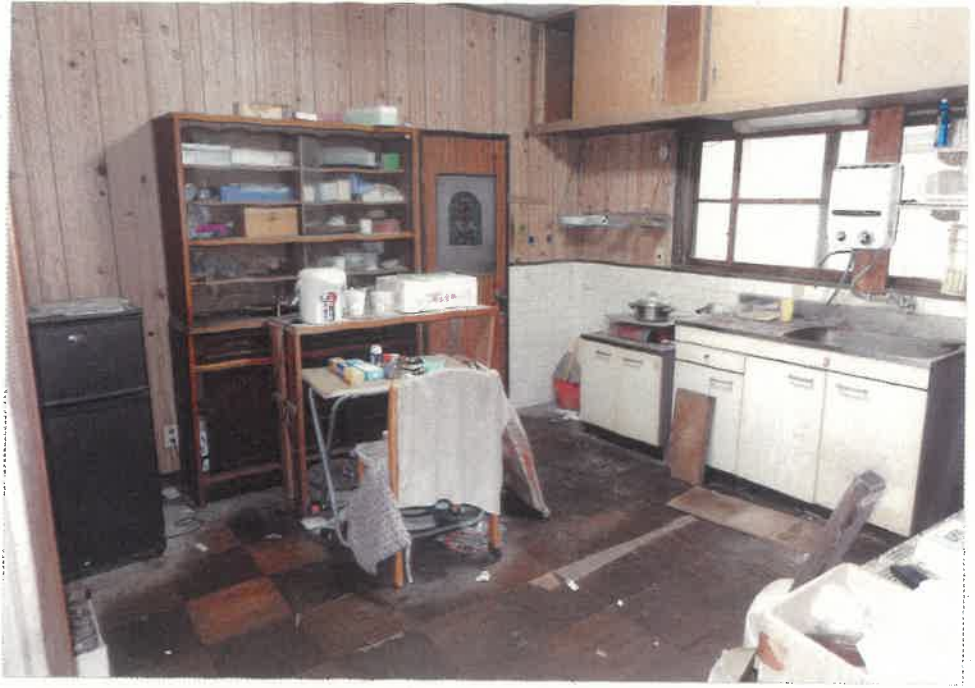
⑤ 屋内の状況 (ダイニング・キッチン)
