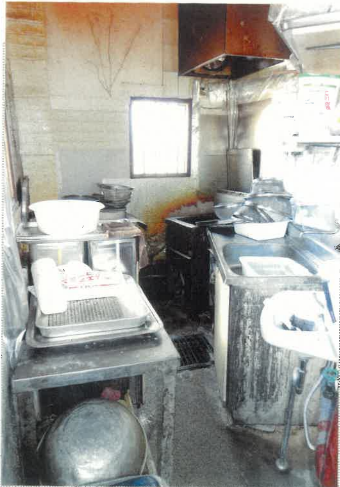
④ 屋内の状況（厨房）
