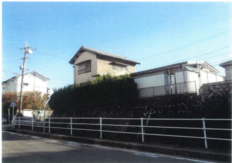
② 物件2建物の外観（北西方向から撮影）
