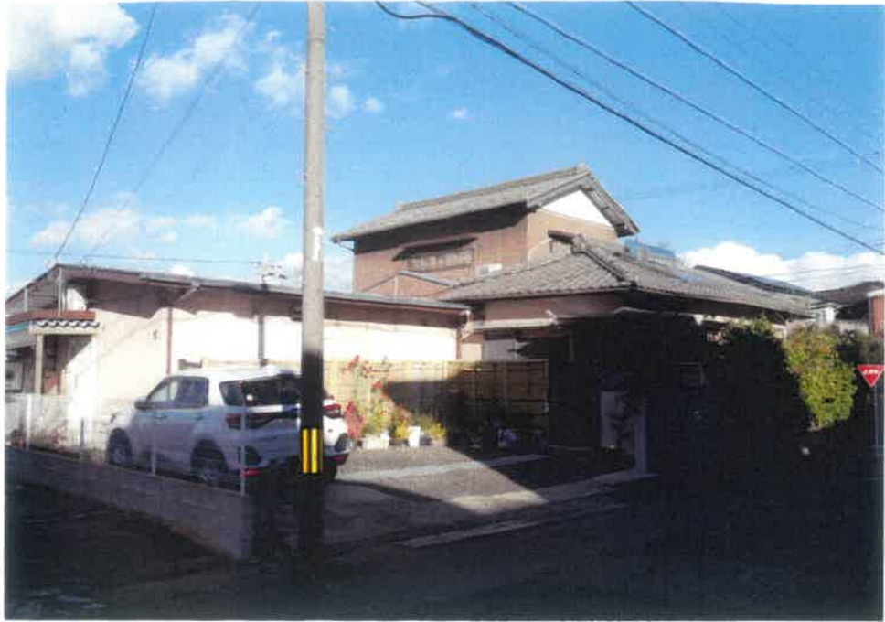
① 物件2建物の外観（南西方向から撮影）
