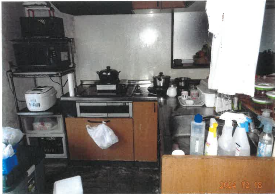
④ 屋内の状況（1階 キッチン）
