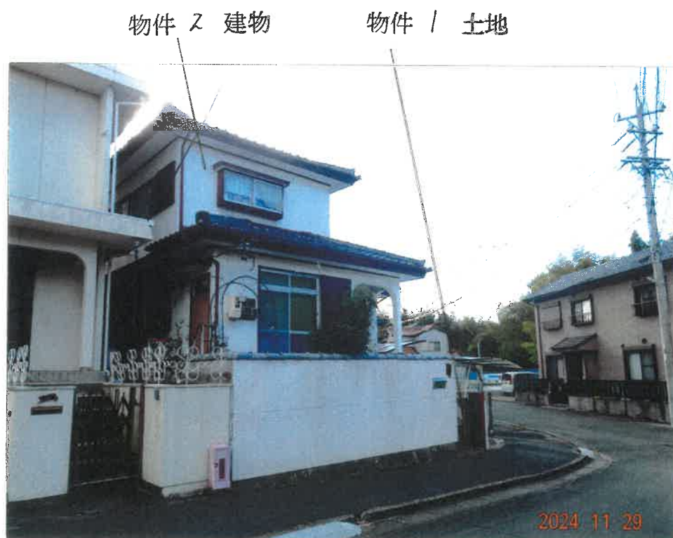
② 北東側から見た物件 1 土地及び物件 2 建物の状況
