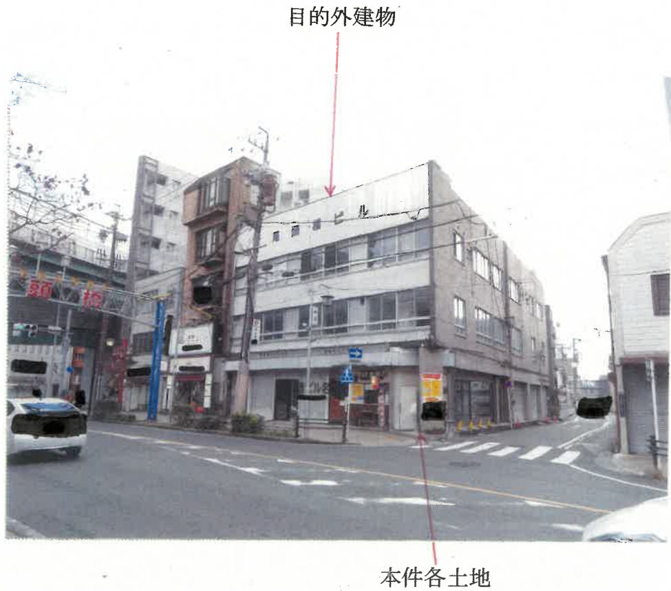
① 本件各土地、目的外建物の外観（北西方向から撮影）
