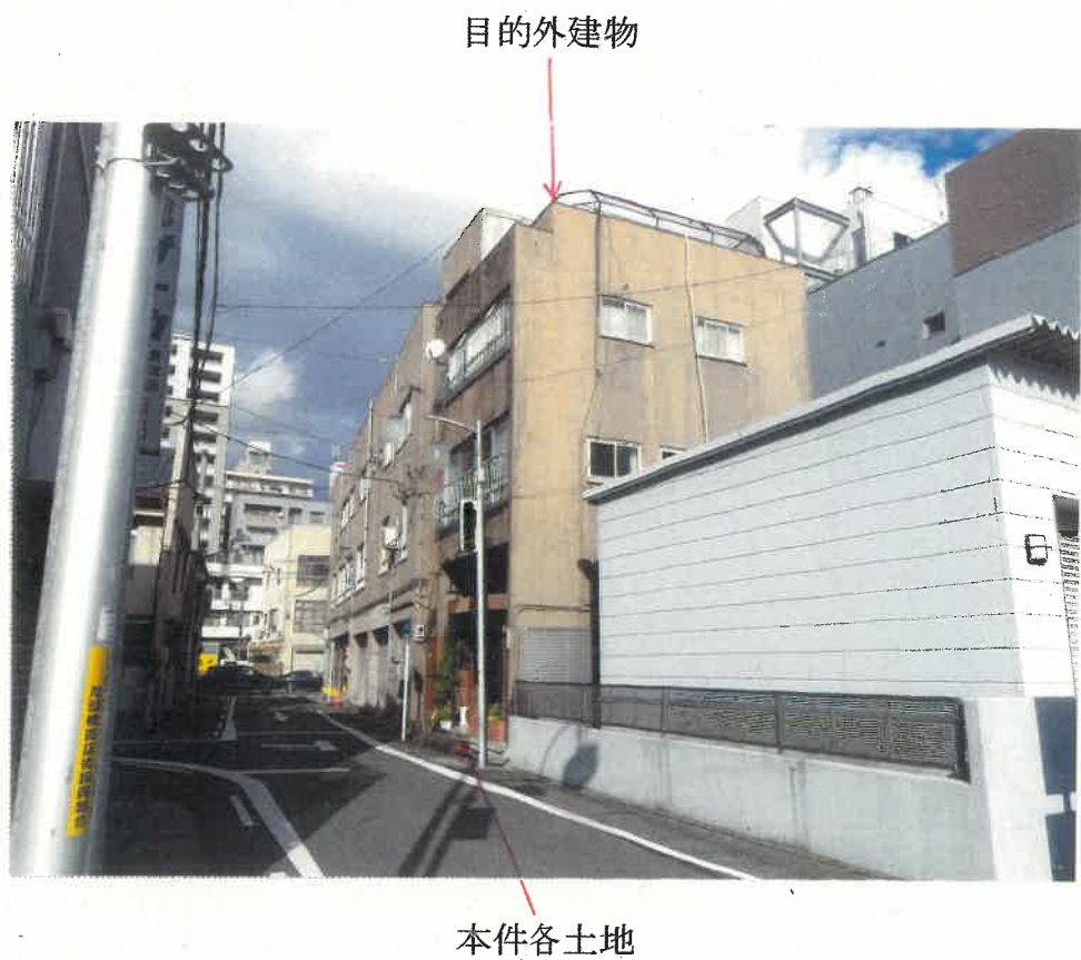
② 本件各土地、目的外建物の外観（南西方向から撮影）
