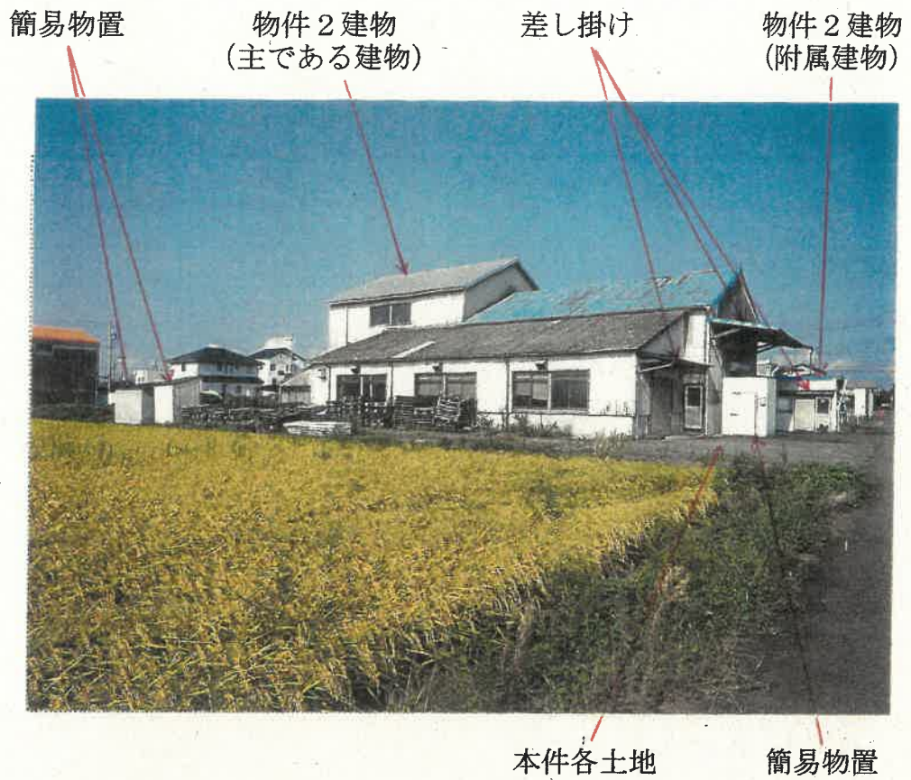
① 本件各土地、物件2建物の外観（北東方向から撮影）
