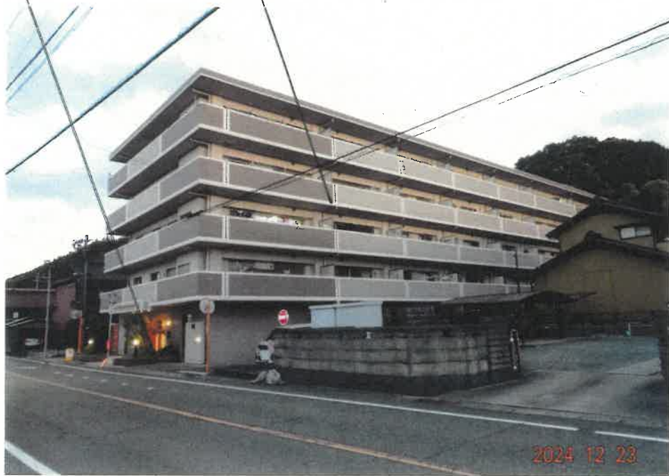
① 西側から見た本件建物を含む一棟の建物、敷地権土地符号1の状況
