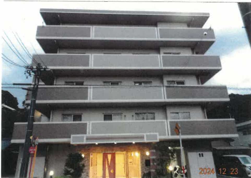
② 北西側から見た本件建物を含む一棟の建物の状況
