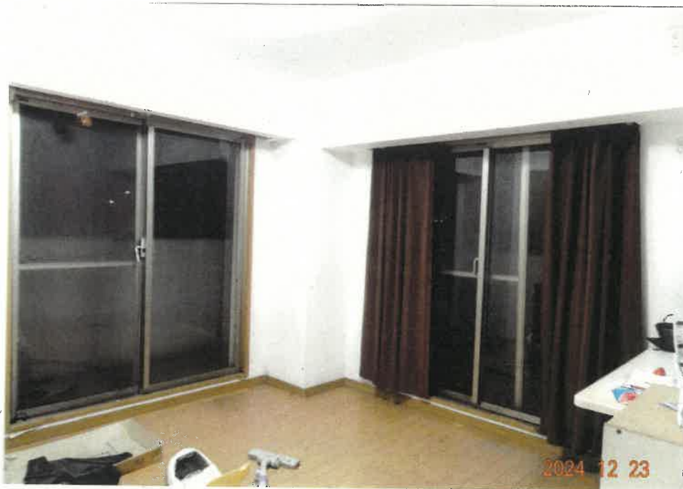
⑥ 屋内の状況（洋室 1）
