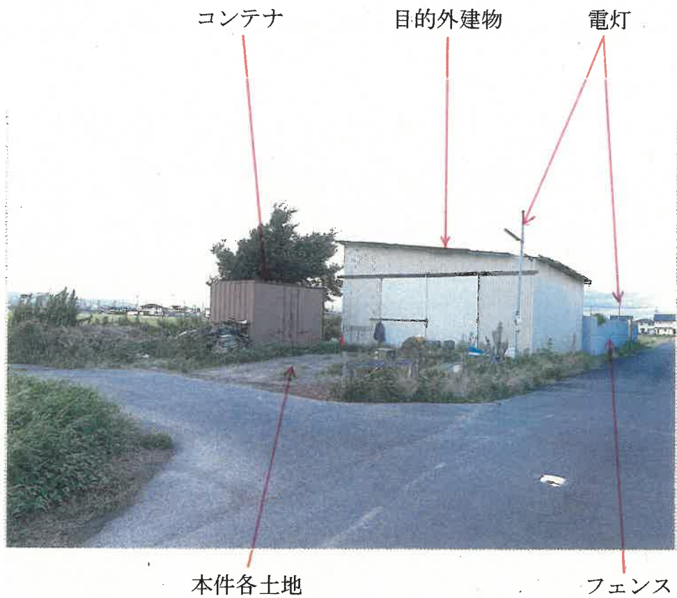
① 本件各土地、目的外建物の外観（南東方向から撮影）
