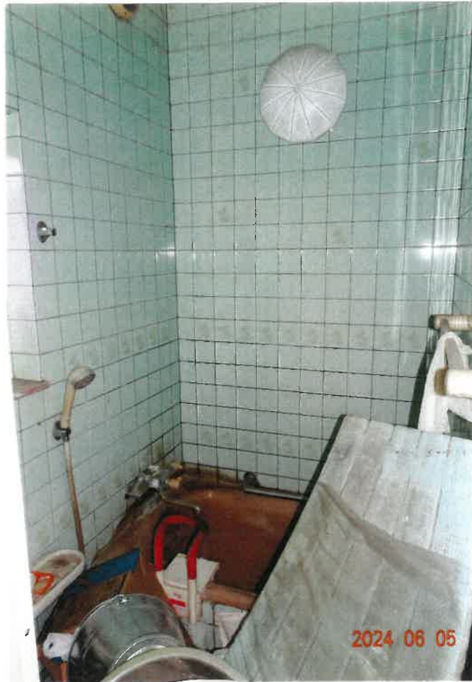
⑬ 物件2建物附属建物符号1屋内の状況（浴室）
