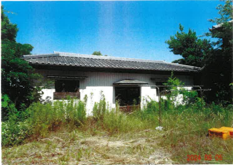
⑰ 物件2建物附属建物符号3の状況
