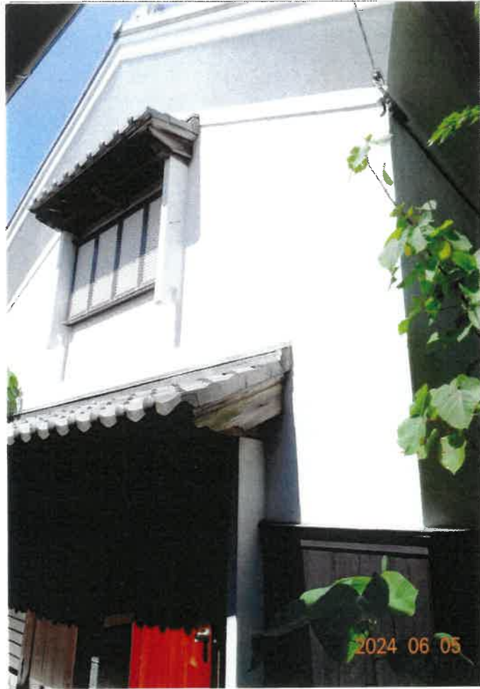
⑭ 物件2建物附属建物符号2の状況
