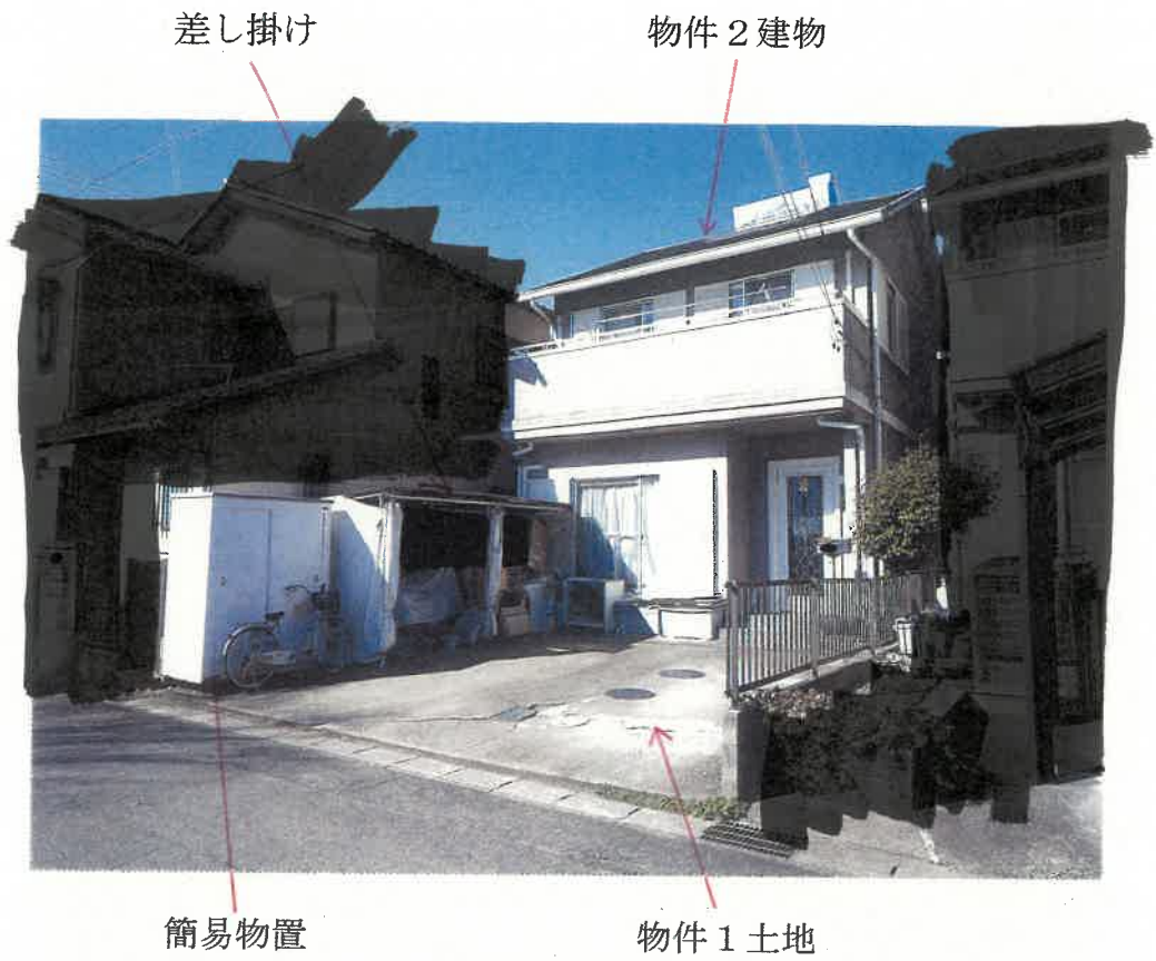
① 物件 1 土地、物件 2 建物の外観（東方向から撮影）
