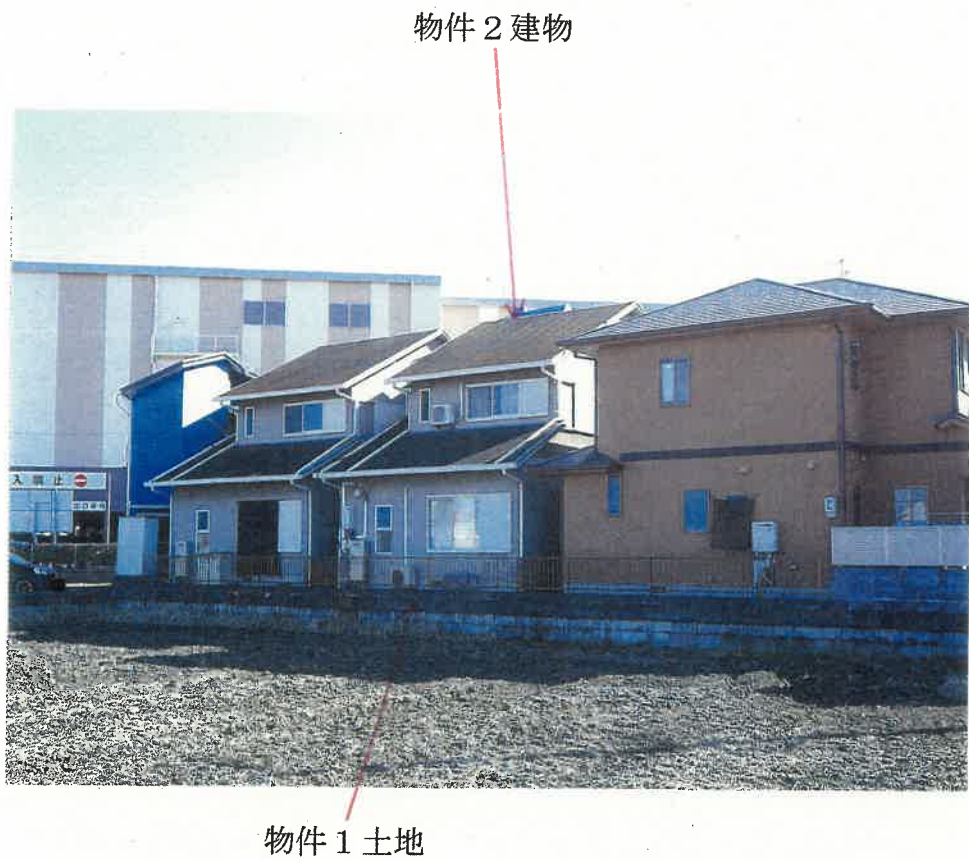
② 物件 1 土地、物件 2 建物の外観（西方向から撮影）
