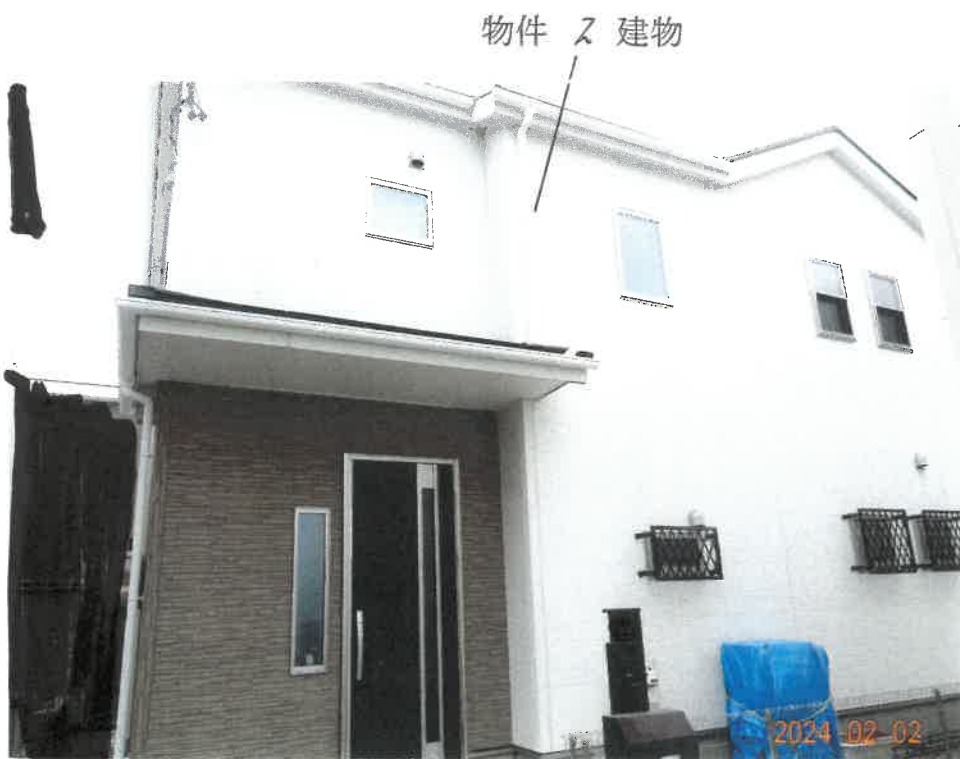
② 物件2建物の状況
