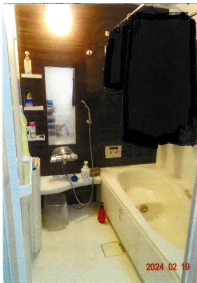
⑥ 屋内の状況（1階 浴室）
