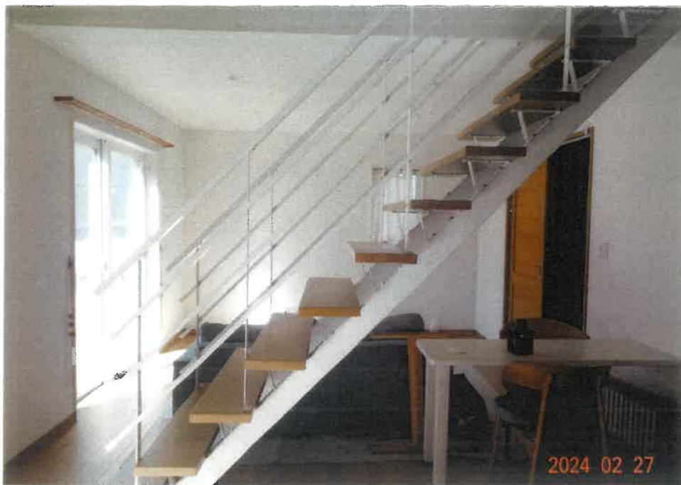
③ 屋内の状況（1階 リビング）
