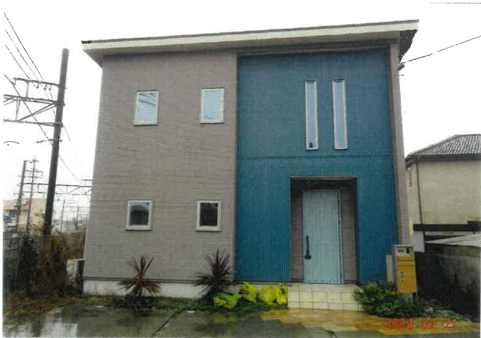
② 物件 5 建物の状況
