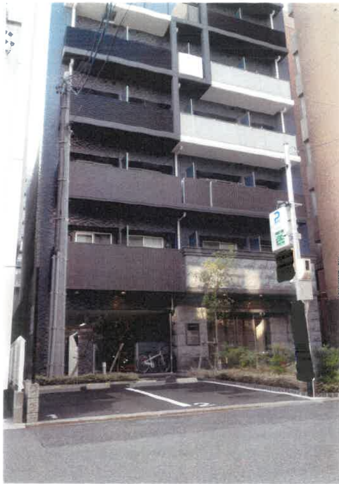
① 物件1建物を含む一棟の建物の外観（東方向から撮影）
