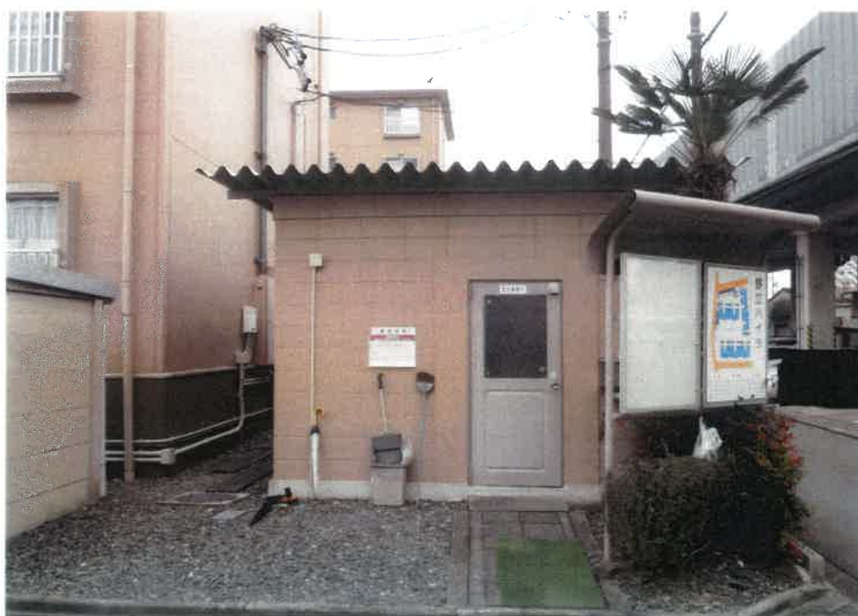
④ 物件2建物の主である建物の外観（管理人室・北方向から撮影）
