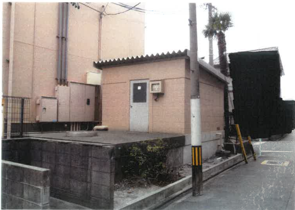
⑥ 物件2建物の附属建物符号2の外観（ポンプ室・北西方向から撮影）
