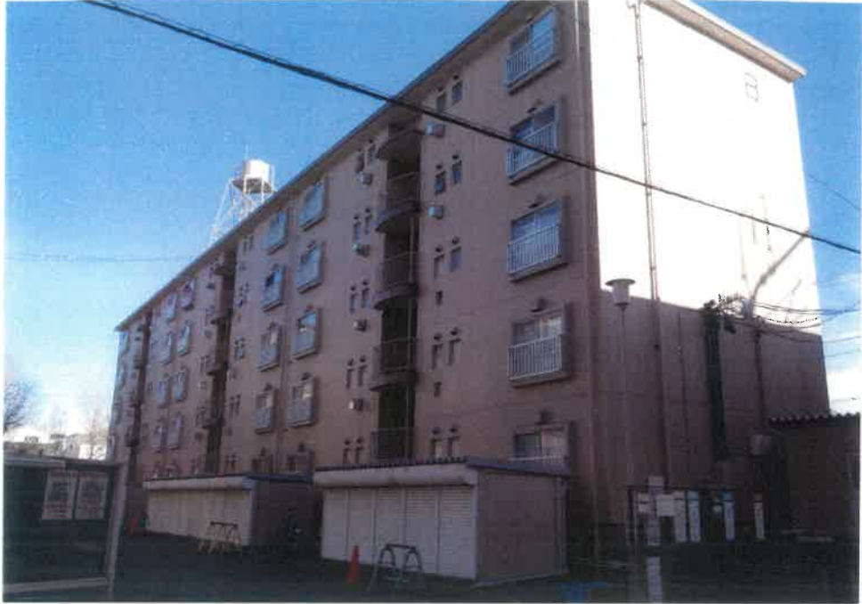
① 物件1建物を含む一棟の建物の外観（北西方向から撮影）
