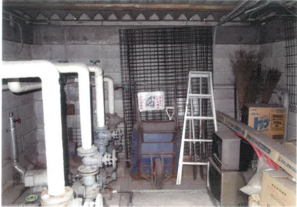
⑪ 屋内の状況（物件2建物の附属建物符号2）
