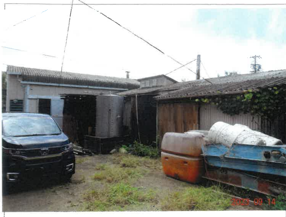
③ 物件 3 建物の状況
