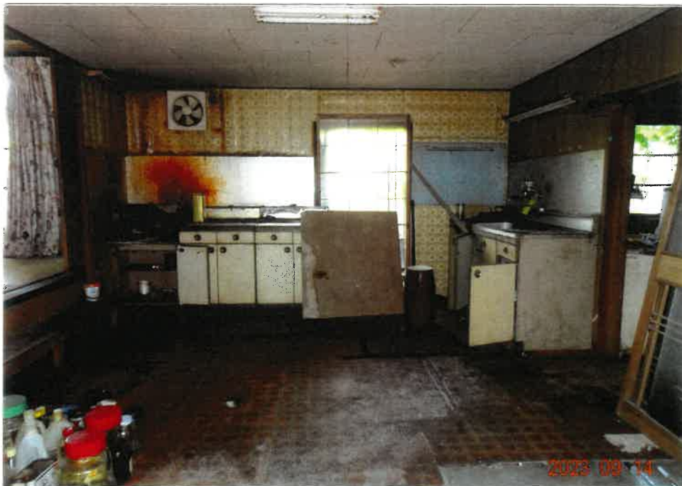
⑧ 物件2建物屋内の状況（1階 台所）
