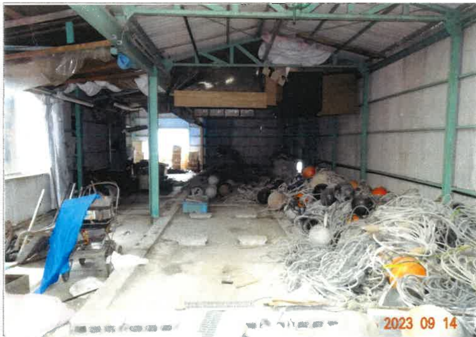
⑩ 物件3建物屋内の状況（作業所）
