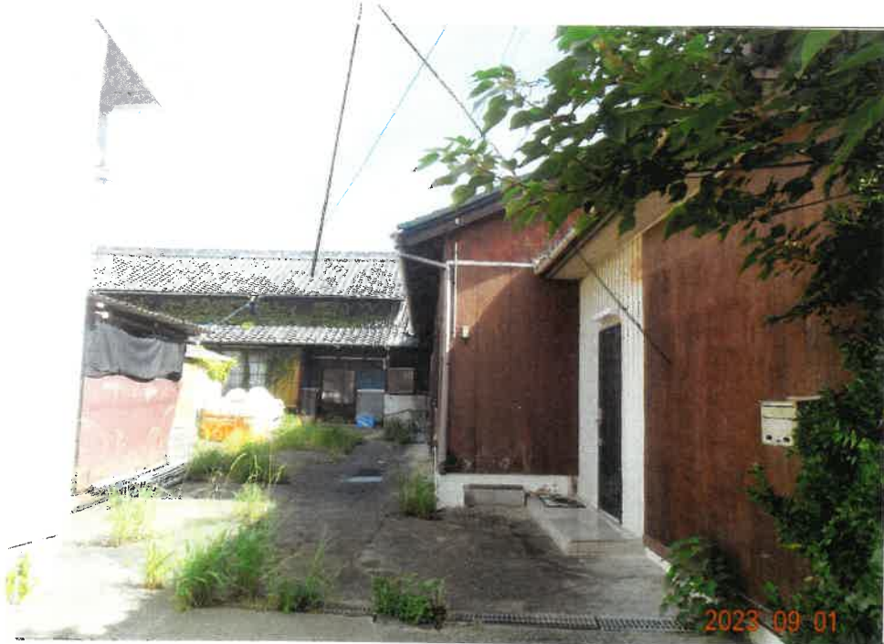
② 物件 2 建物の状況
