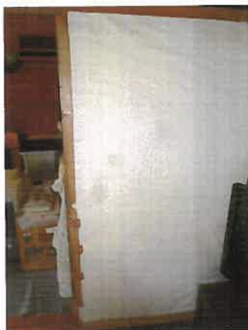
26 同上 襖の修復跡
