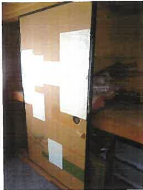
17 同上 襖の修復跡
