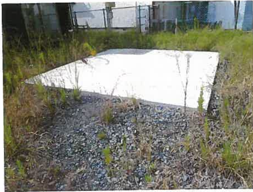
4 用途不明 の コンク リート
