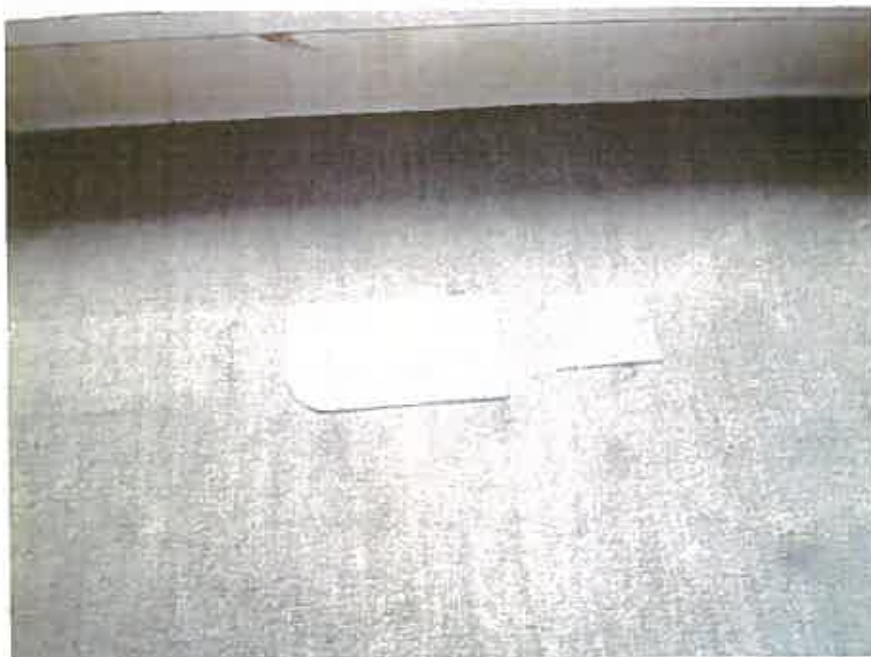
12 同上 床の 補修跡
