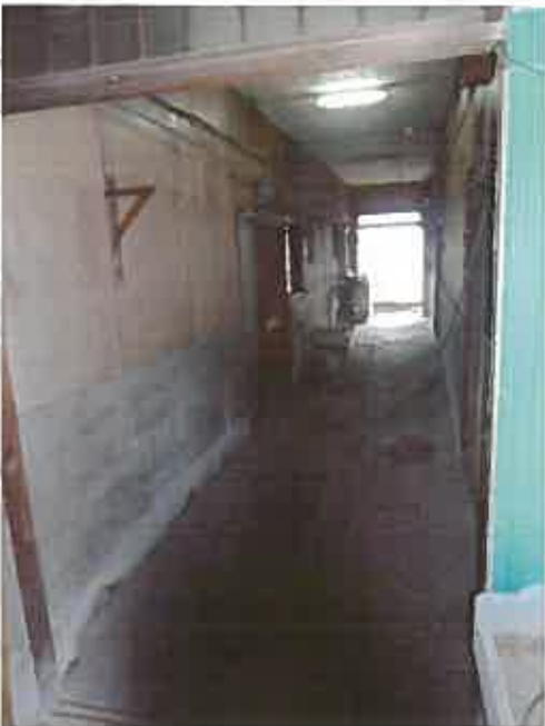
33 物件3 1F廊下
