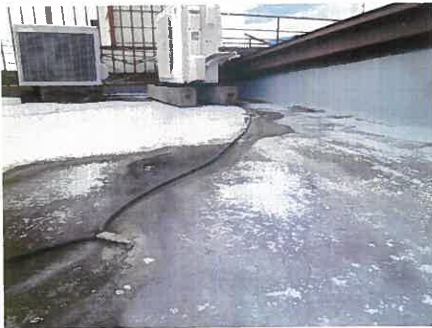
23 同上 防水塗装 の状況
