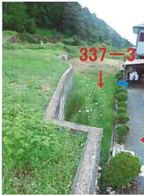
7 段差・擁壁 の状況
