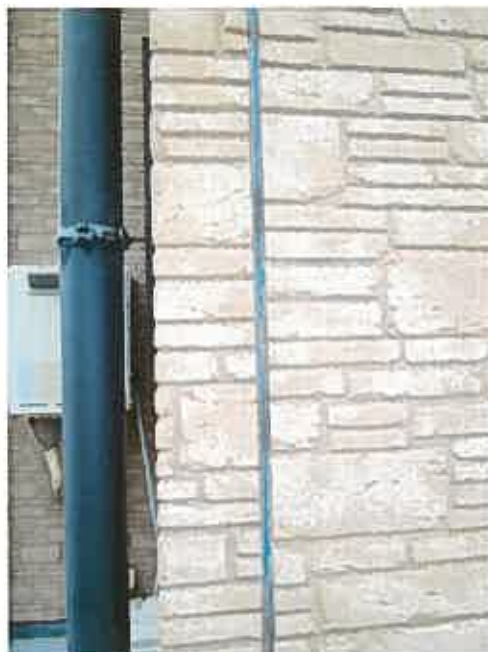
3 外壁目地 の状況
