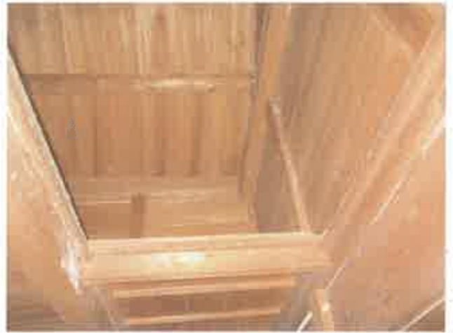
附属建物 符号 3 (天井がない部分)
