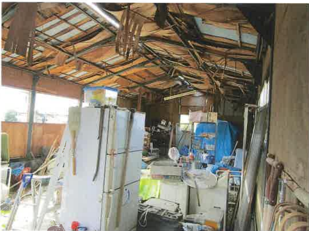
物件3 附属建物符号4 内部
