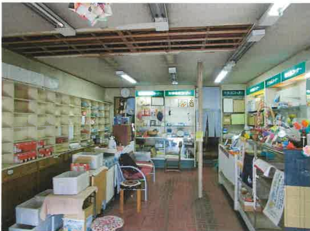
物件3 主である建物内部
