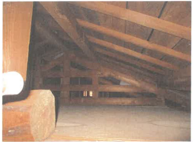
屋根裏収納内
