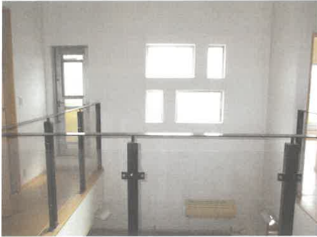
主建物 2階 吹抜
