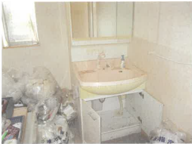
主建物 1階 洗面
