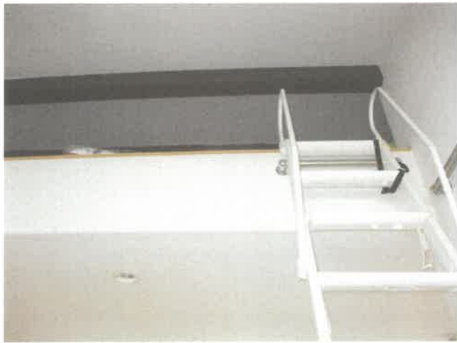
主建物 2階 ロフト入口
