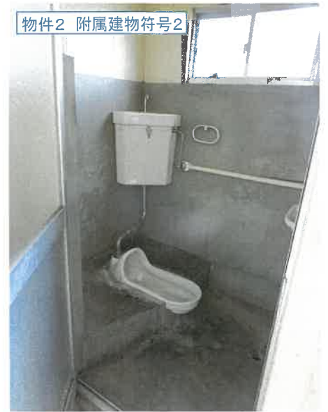
附属資料9 現況写真
