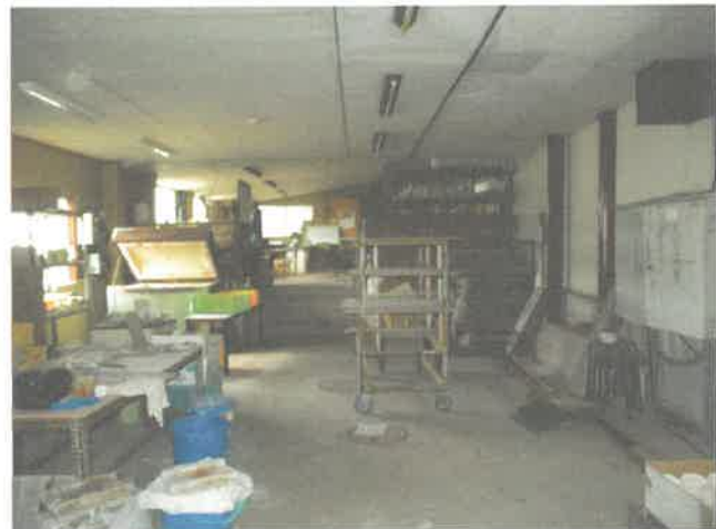
物件4 主建物1階
