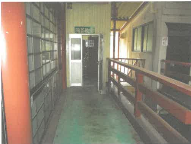
物件 4 主建物 1 階
