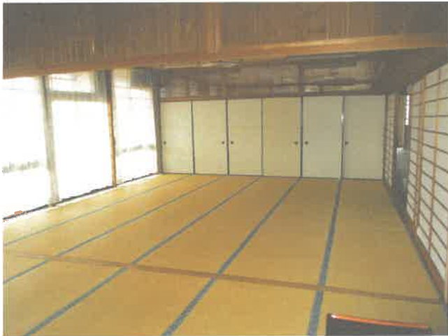
物件 5 主建物 2階
