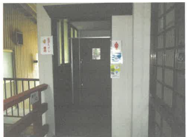
物件5 主建物1階
