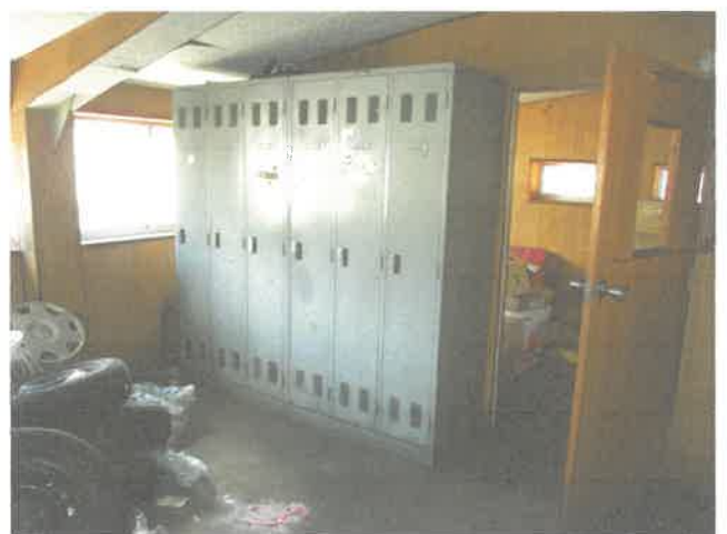
2階 ロッカー室
