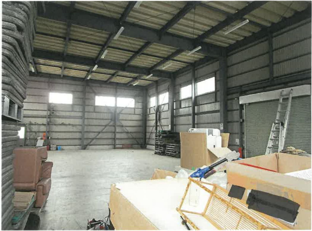
物件2 主である建物内部
