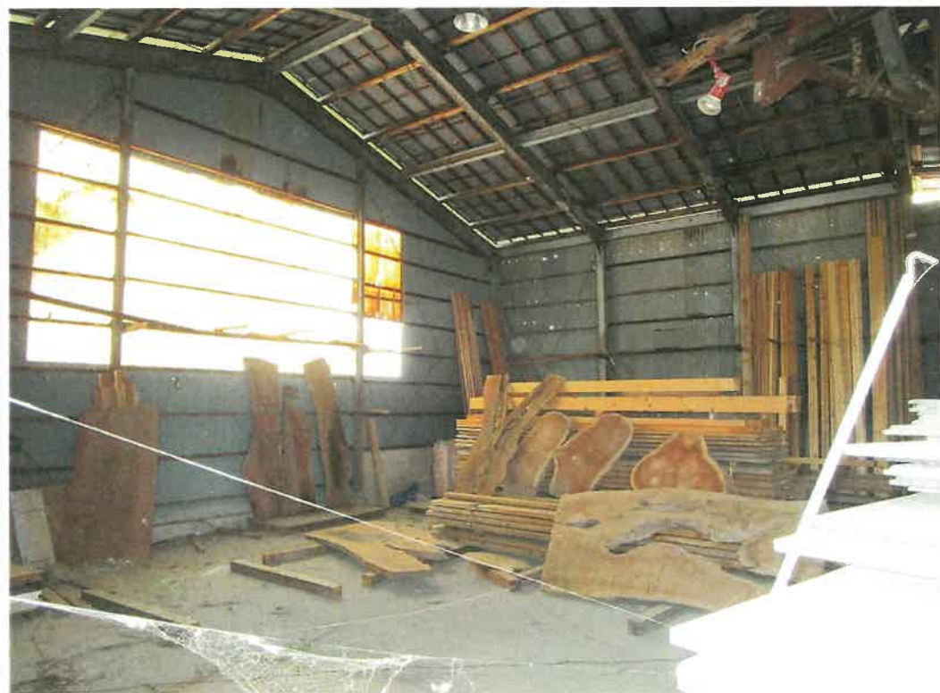
物件4 未登記附属建物内部
