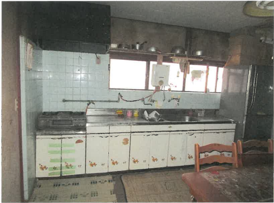
物件2 主である建物内部
