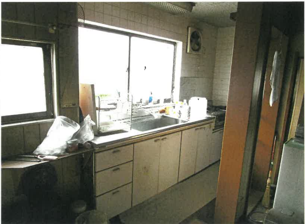
物件3 主である建物内部
