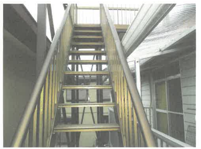
ベランダから屋上への階段
