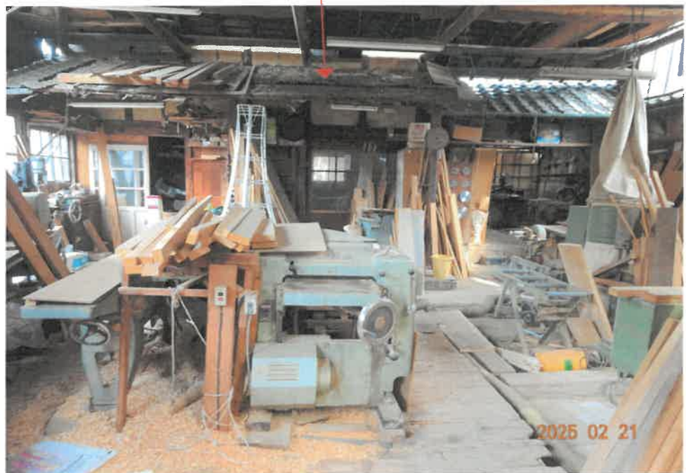
⑪ (物件 5 屋根瓦欠落箇所)
