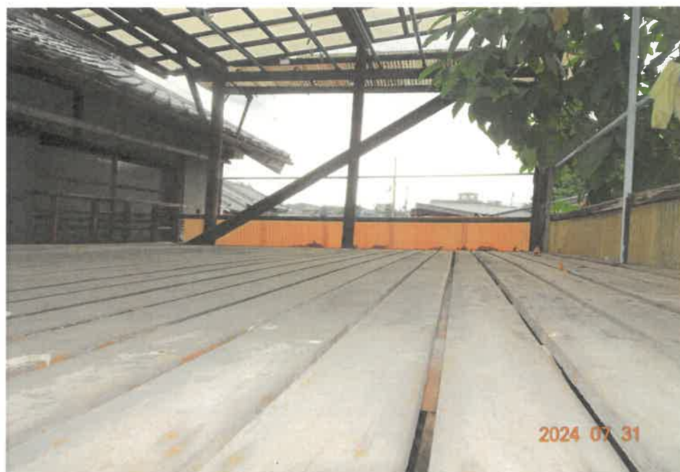
⑬ (主である建物1階屋根上 物干場)
