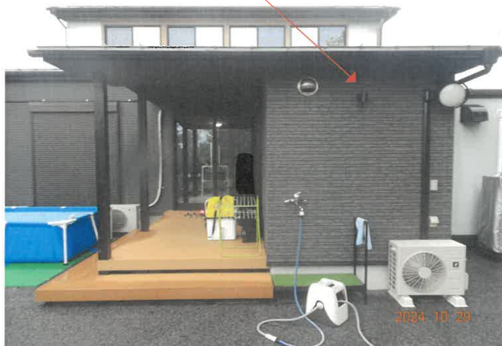
⑨ (1階南西側未登記増築部分 外観)
