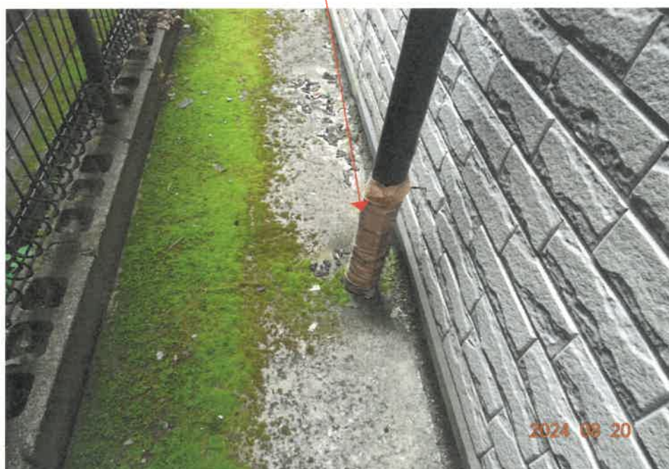
⑫ (雨樋 補修箇所)
