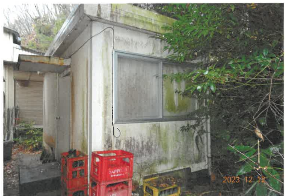
④ (物件3 附属建物)
