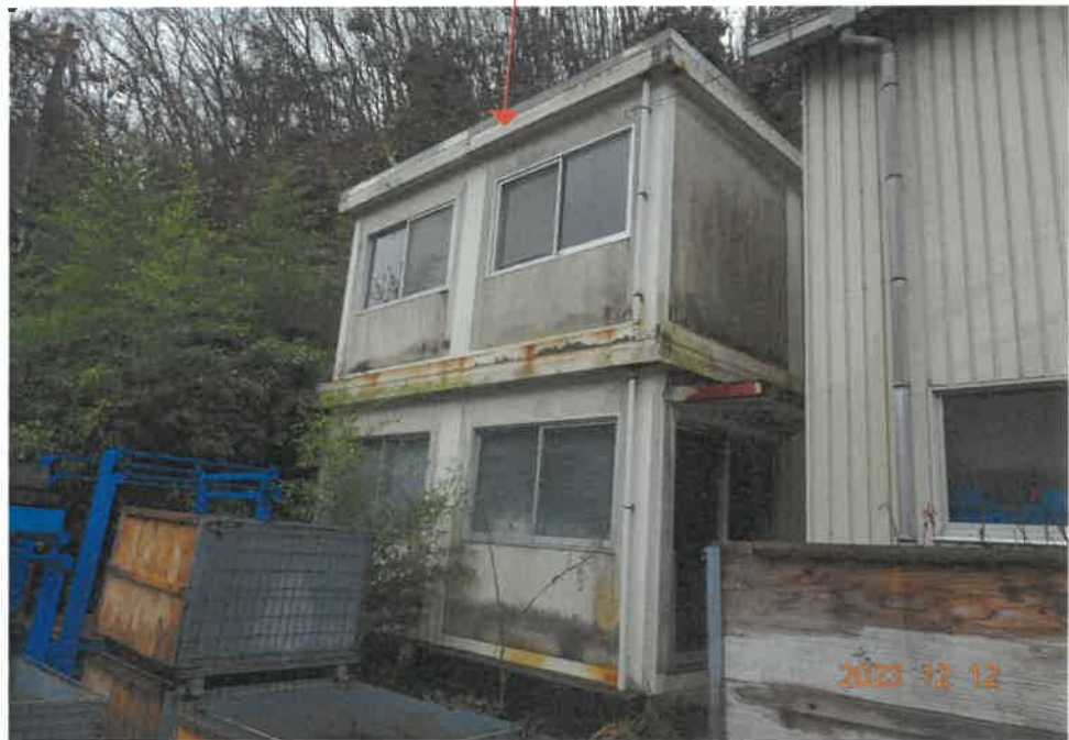
② (物件2 附属建物)
