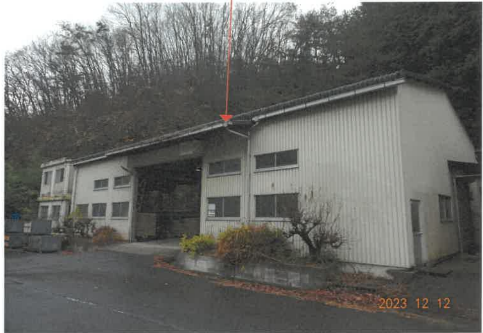
① (物件2 主である建物)
