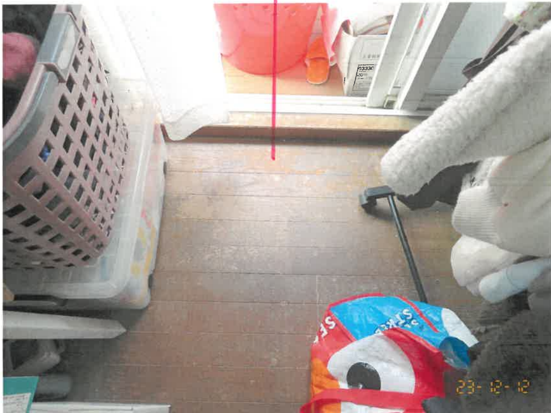
フローリングが剥がれている
