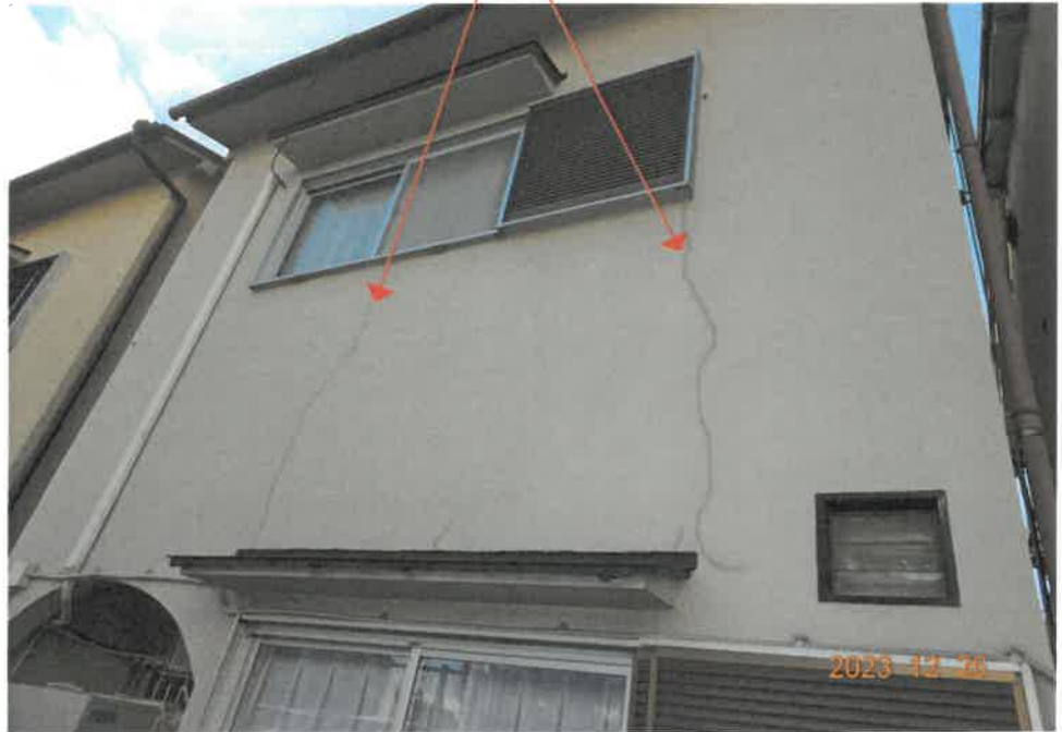
⑦ (外壁クラック補修跡)
