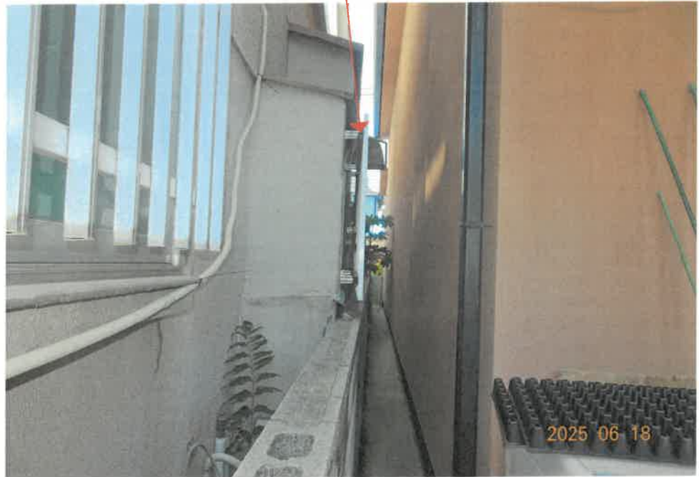
⑮ (越境している西側隣接建物の換気扇及び格子)
