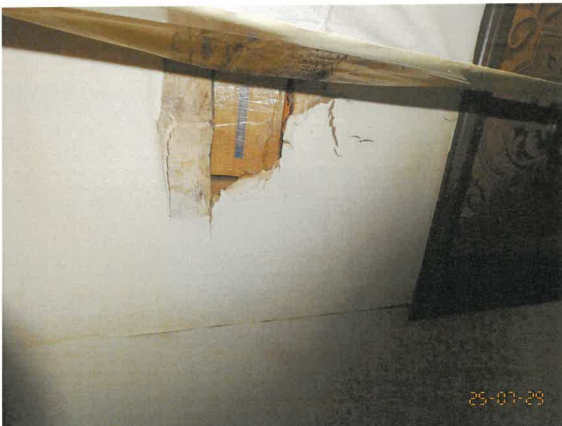
雨漏りによる天井損傷
