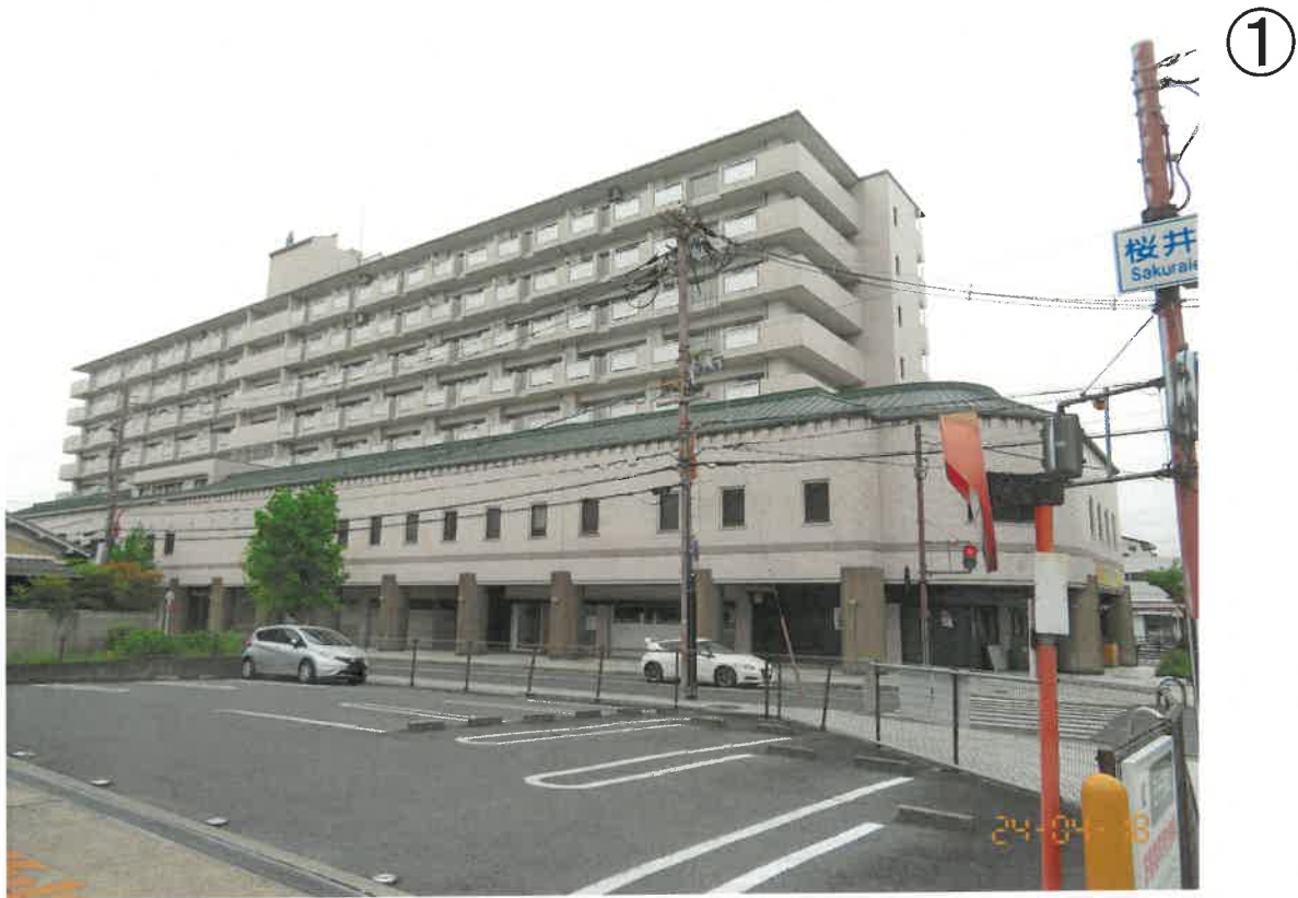
一棟の建物全景
